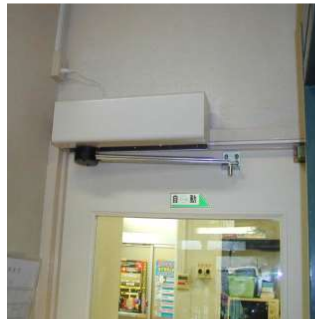
【施設厨房入口】
